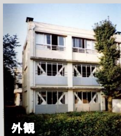
市立小学校(在来鉄骨枠ブレース)
