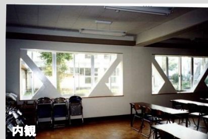
市立小学校(在来鉄骨枠ブレース)
