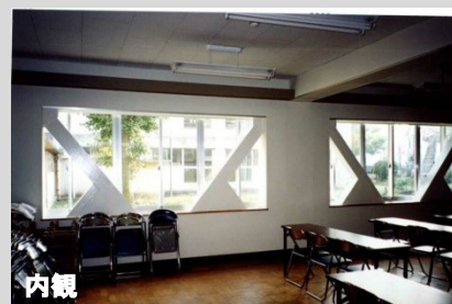
市立小学校(在来鉄骨枠ブレース)
