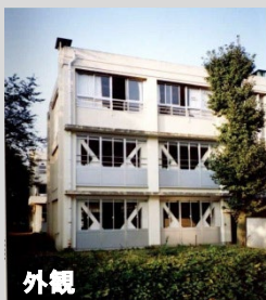
市立小学校(在来鉄骨枠ブレース)
